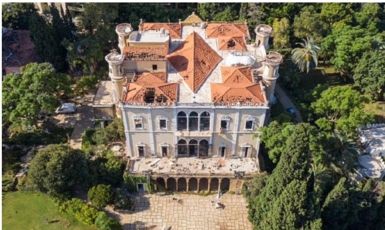
Figura 3: il palazzo storico e il museo di Sursock danneggiati gravemente
