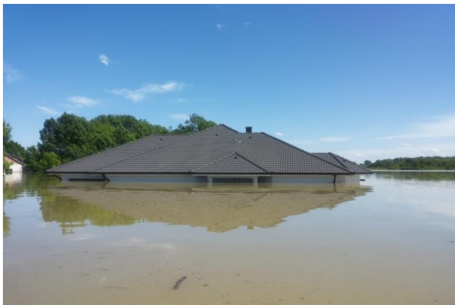
Casa alluvionata a Odžak, Bosnia Erzegovina
